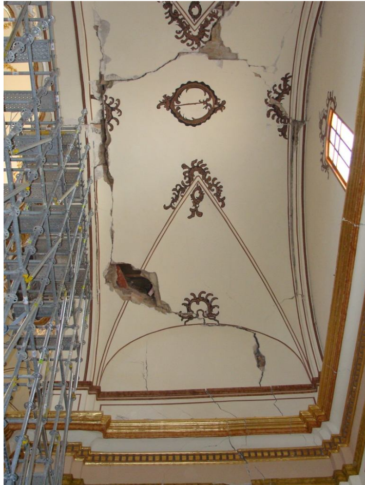
Bóveda de la nave lateral.
